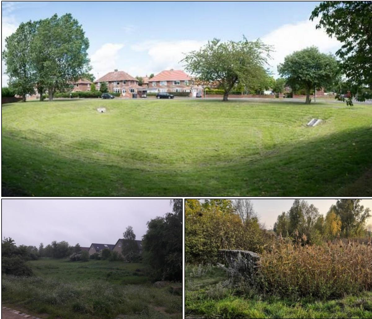
Abbildung 5: Naturnahe Regenrückhaltebecken (rechts: mit Schilfbewuchs) [oben: <http://www.susdrain.org>, unten: IPS, 2019]
