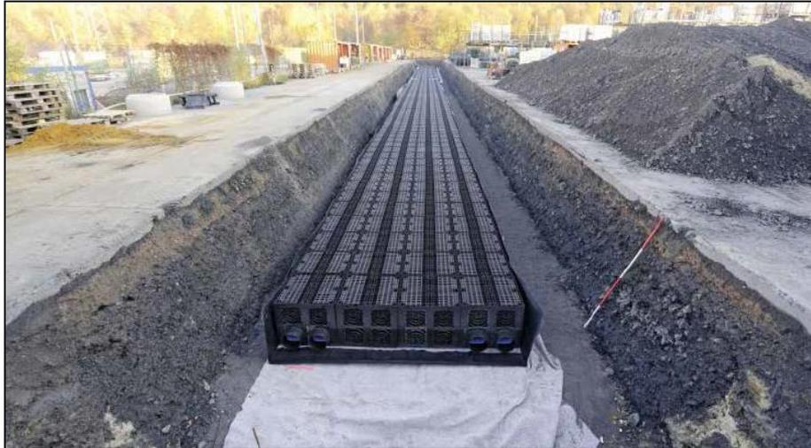
Abbildung 6: Ausführung einer Rigole mit Kunststofffüllkörper der Fa. Rehau [Quelle: Fa. Rehau, 2016]
