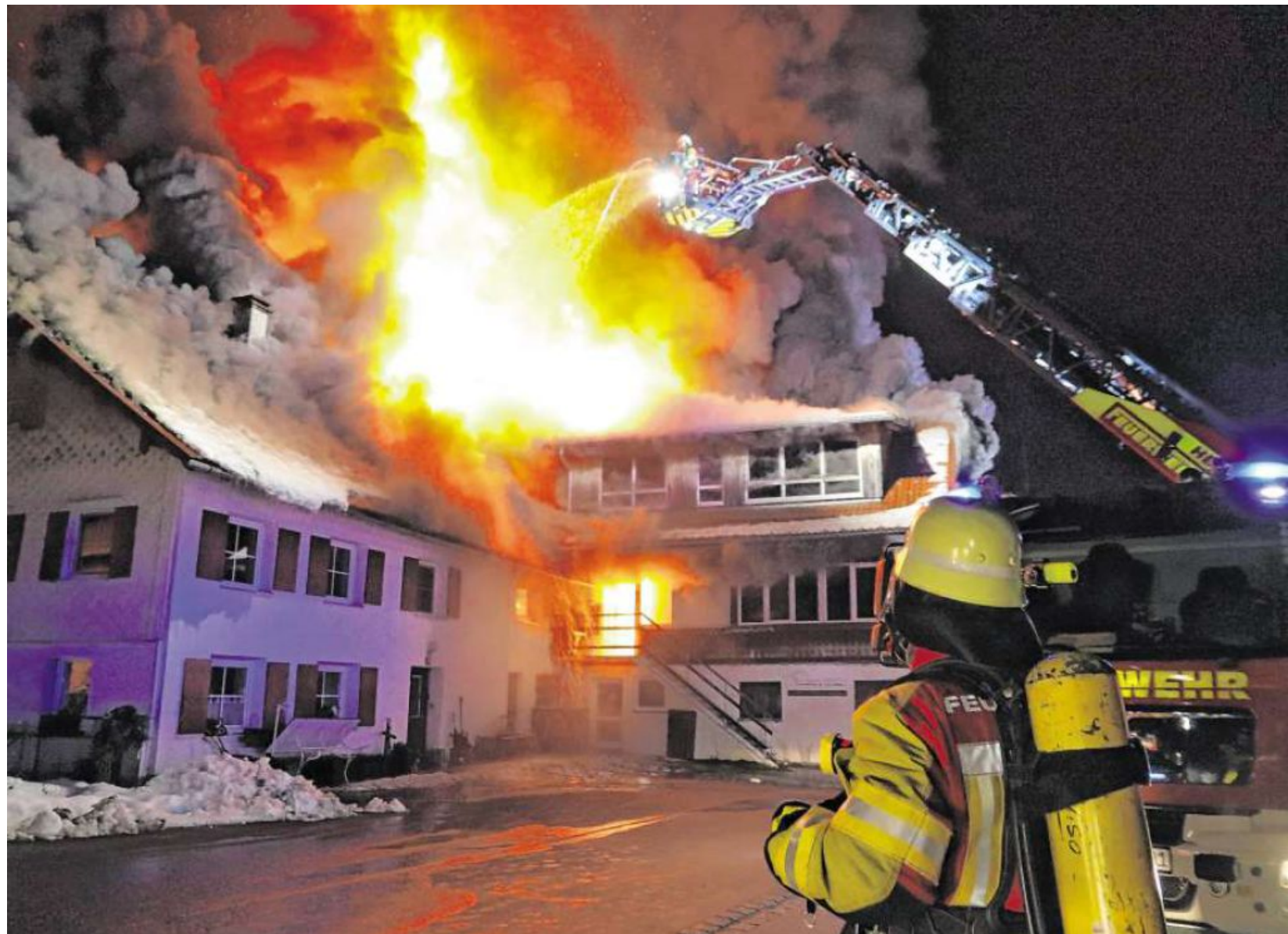
Vom Dachstuhl ausgehend brannte am Freitagmorgen ein Wohnhaus mit Stadel und Zimmerei in Waltenhofen nieder. Die Rettungskräfte konnten Bewohner sowie fünf Pferde und eine Katze vor den Flammen retten.
