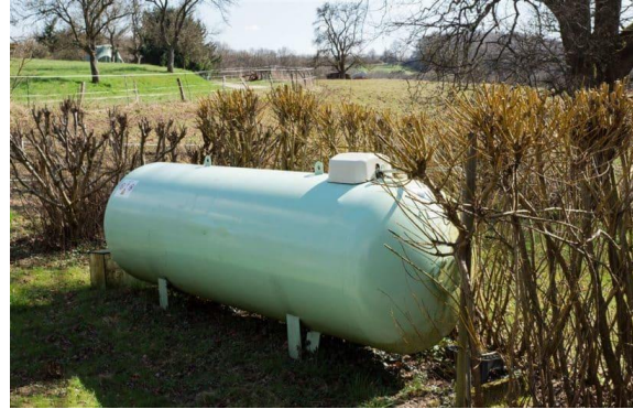
Abbildung 26: Oberirdischer Flüssiggastank
