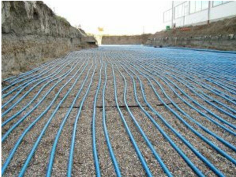
Abbildung 12: Beispielhafte Darstellung Erdwärmekollektor [5]
